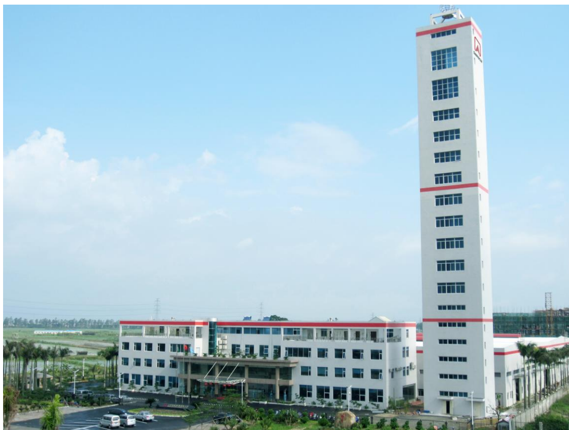
三洋电梯（珠海）有限公司（正面图）
