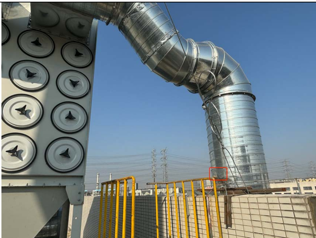
废旧电视机、显示器拆解线处理前开口
