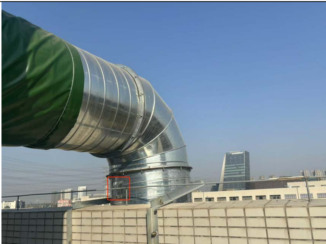
废旧电冰箱、冷柜拆解线（二线）处理前开口
