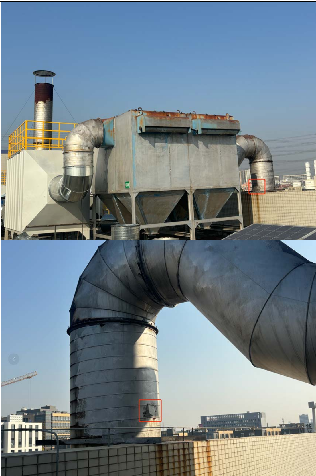
废旧空调拆解线（一线）和废旧洗衣机拆解线处理前开口
