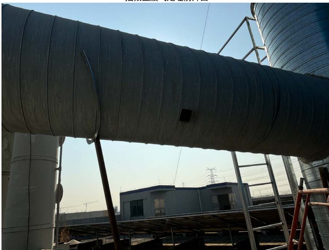
废旧电冰箱、冷柜拆解线（一线）废气处理前开口
