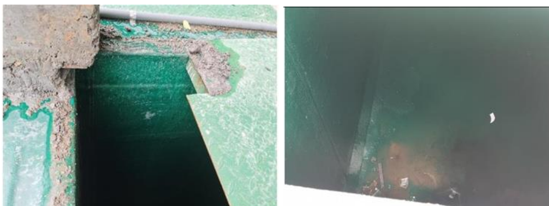
综合废水处理站地下池体防腐防渗
