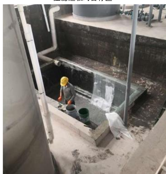
渗滤液收集池防腐防渗
