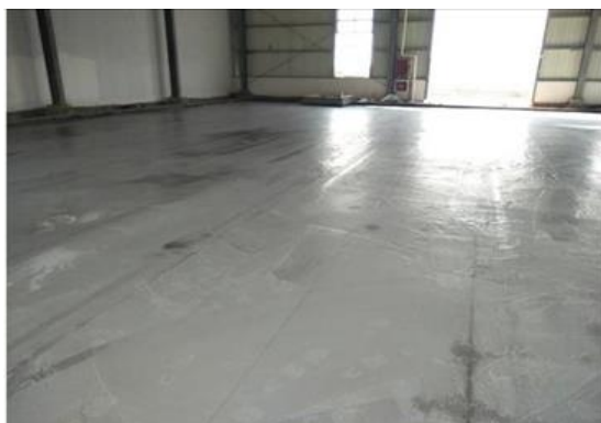
地层水泥硬化施工
