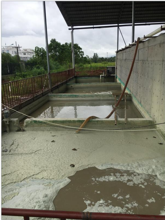
二级沉淀池+二级清水池（本项目新建）
