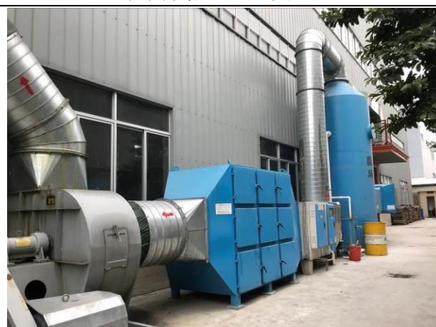
图 4.1-8 “金属铝箱过滤网预处理粉尘+矿物油喷淋吸收+低温等离子+活性炭吸附”处理设施
