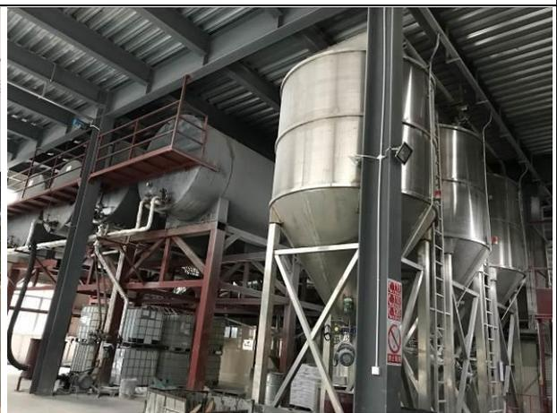
图 3.2-8 原材料仓（罐区）
