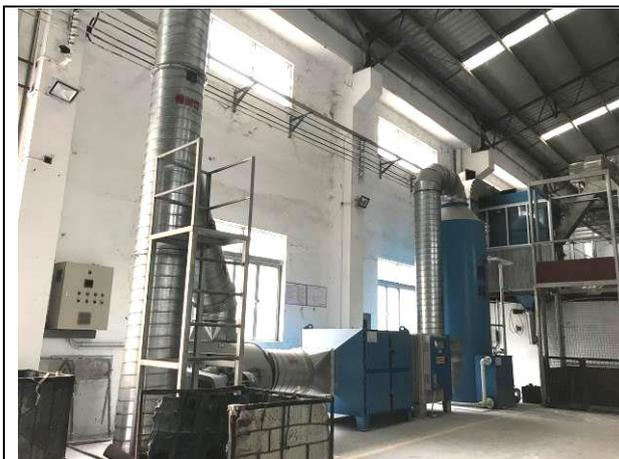
图 4.1-6 “旋流板洗涤净化塔+低温等离子+活性炭吸附”处理设施
