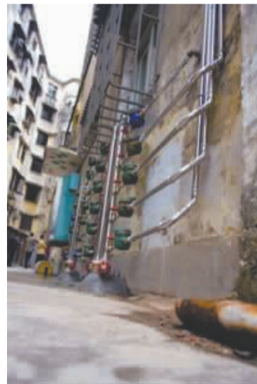
更换“高龄”供水管,实现安全优质供水。
